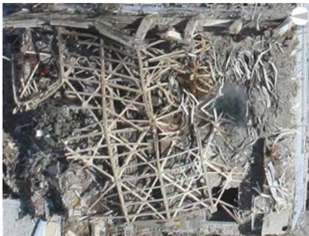
図6 3号機オペフロ大型瓦礫撤去開始前の状況
