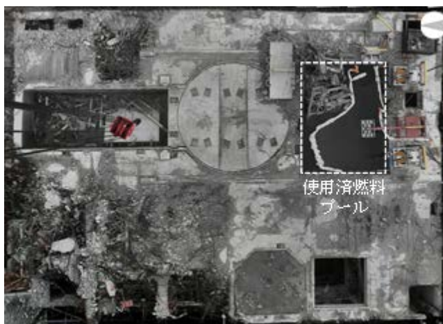
図7 3号機オペフロ大型瓦礫撤去完了後の状況
