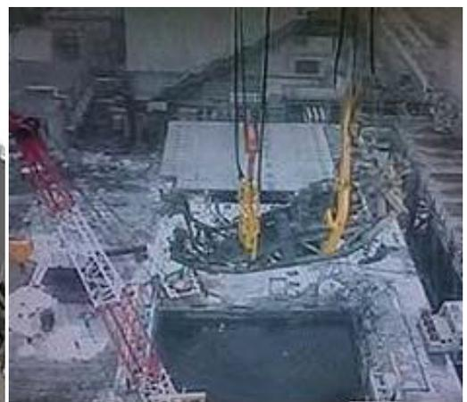
図10 燃料交換機吊上げ写真
