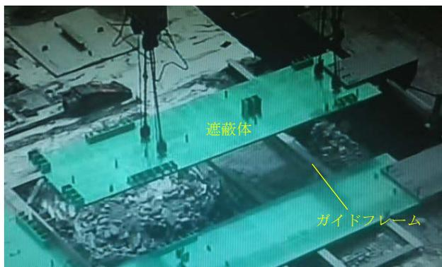
図 16 遮蔽体設置状況(B 工区)
