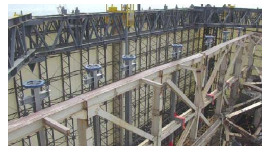
写真8 ミストノズルユニット設置状況 (東面) (東面7箇所、西面6箇所)
