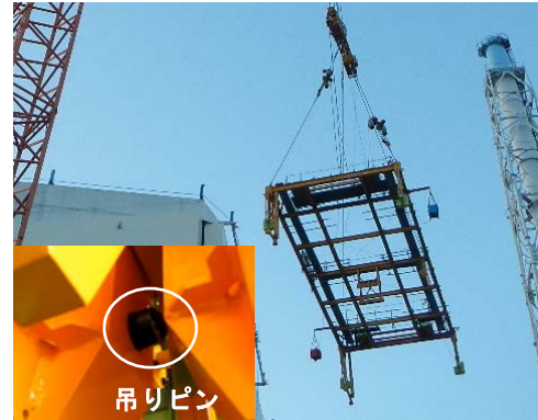
写真2 屋根パネル吊り治具、自動玉掛装置
