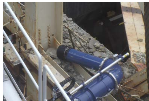
写真4 小ガレキの吸引状況
