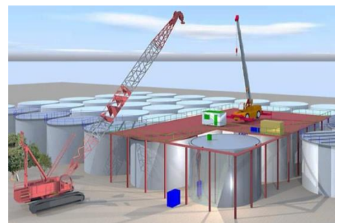
図1 作業用構台からのアプローチ
