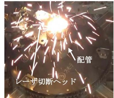
図2 熱交換器 給水配管切断状況
