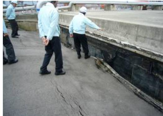
図5 中越沖地震時の地震動と地盤の相対変位による損傷液状化に伴う地盤沈下の差により生じた段差
