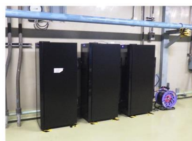
図2 地下2階の原子核乾板 設置状況
