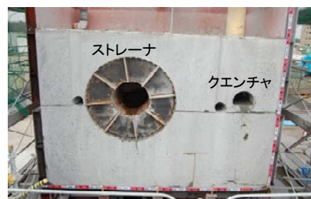
図 3 コンクリート充填状況
