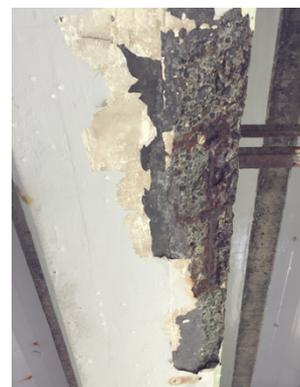
Fig.1 : 表面に損傷が見られる実橋梁の下フランジ部
