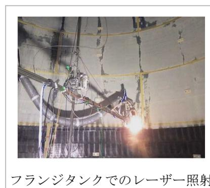
フランジタンクでのレーザー照射
