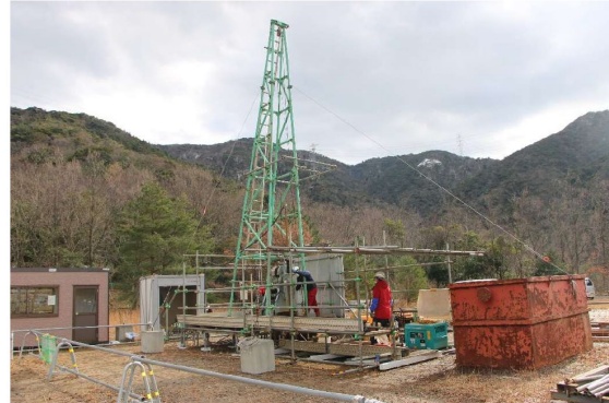
図4 ボーリング作業（2021年1月18日撮影）
