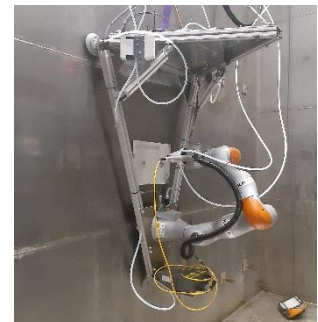
図 レーザー除染システム
