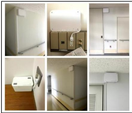
図 8 ネットワーク機器設置イメージ
