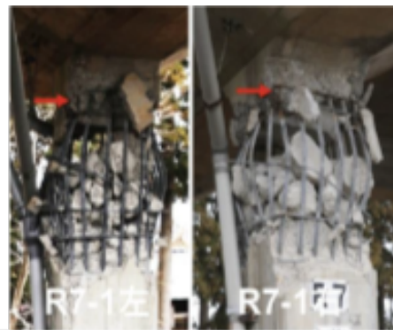
第1中曽根橋（矢印は打継目） 図 2 R7橋の第1柱頭部の破壊状況
