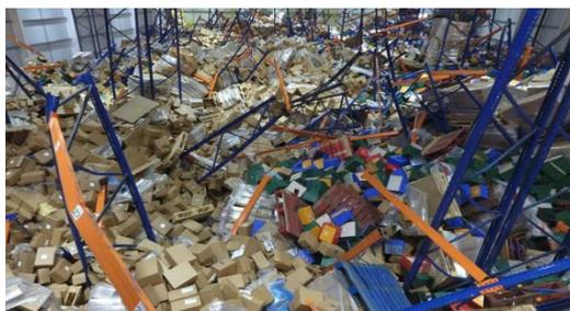
図-2 ラック崩壊事故後の被害の様子[1]
